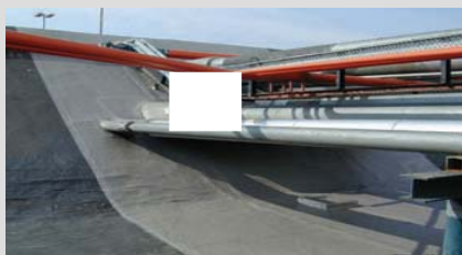
Abdichtung von bestehenden Bereichen
