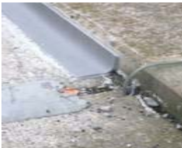
Bandverlegung flach auf die Bauteiloberfläche
