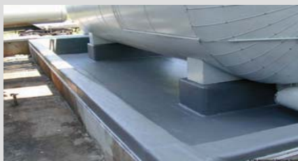
Versiegelung von Betoneindämmungen
