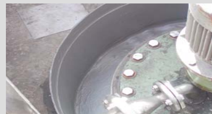
Versiegelung von Schächten, Pumpen usw.
