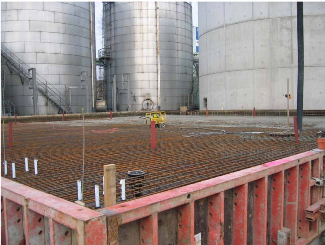
Errichtung der Betonbodenplatte
