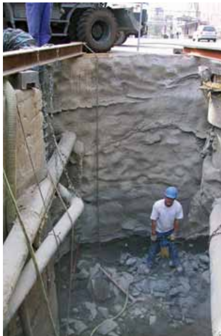
Abteufen einer Baugrube, T = 5,70 \text{ m}
