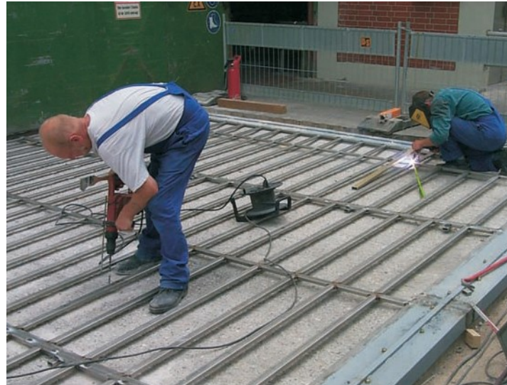
Verlegung eines Gitterrohrrahmens
