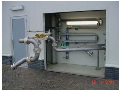
Bodenverladearm im verschließbaren Schutzraum montiert
