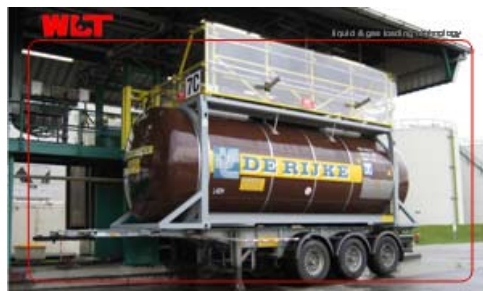
Pneumatische Absturzsicherung mit Wetterschutz
